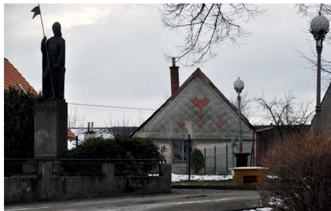
Neobyvatelná nemovitost je již zabezpečena proti vstupu.
