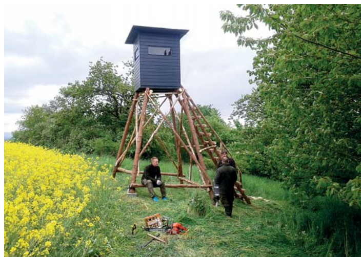
členové spolku při stavbě nové kazatelny.
