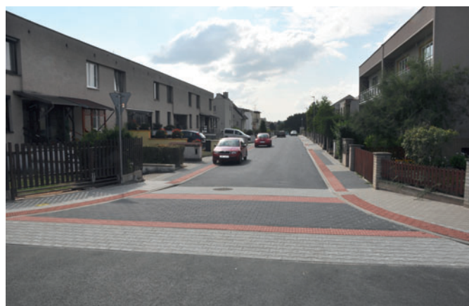
Ulice Severní po zrealizované rekonstrukci. FOTO: Štěpán Tomašik
