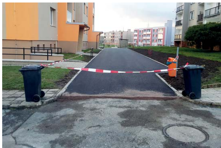
Rozšíření přístupové komunikace v ulici Školská. FOTO: Štěpán Tomašík
